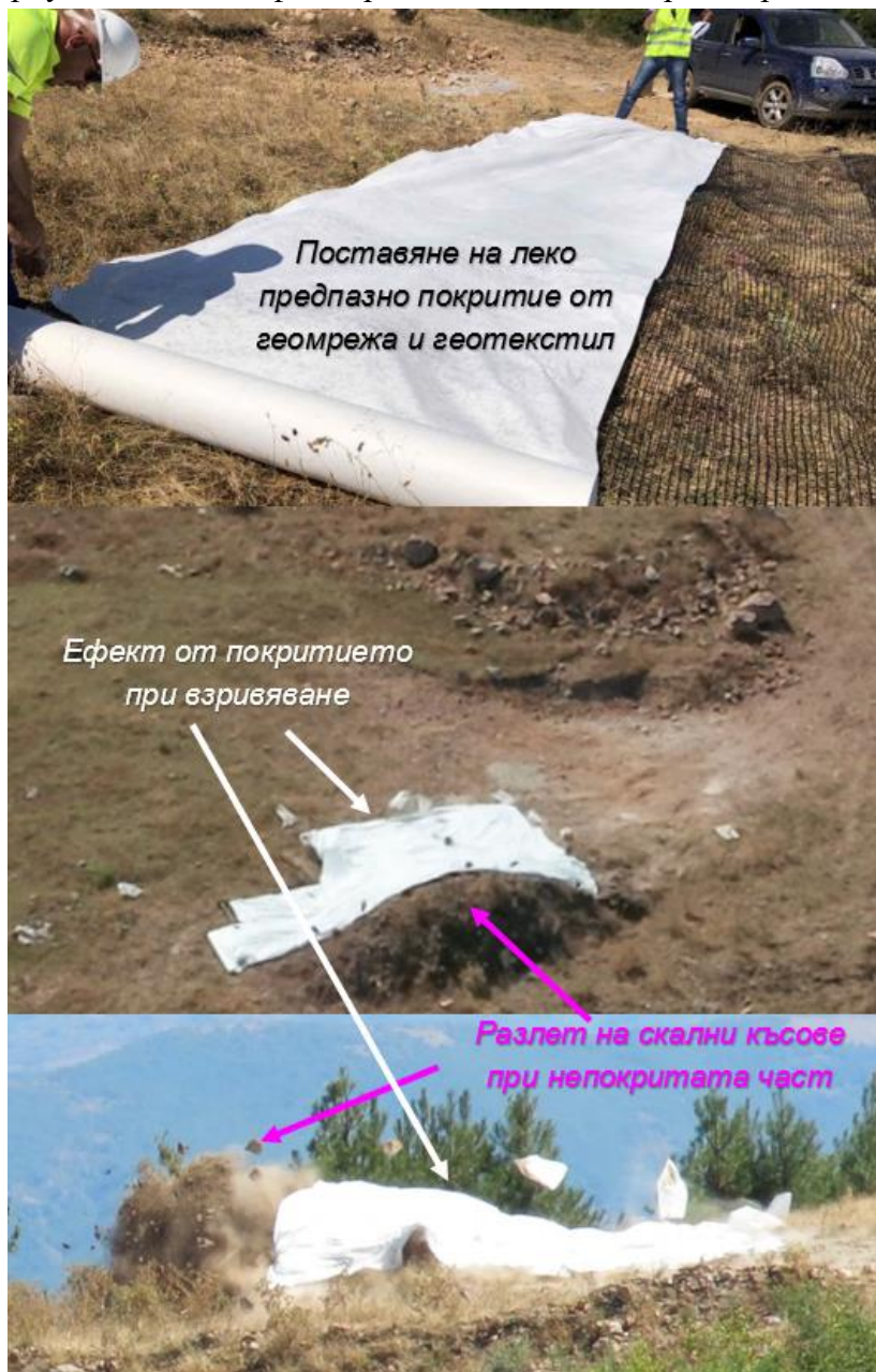
Фигура 1.2-3. Експериментални взривни работи в друго находище. Принцип на поставяне на леко покритие от геомрежа и геотекстил. Ефект при взривяване.
