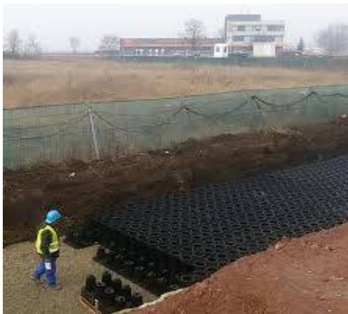
Фигура 1.4.2. Инфилтрационна отводнителна система
