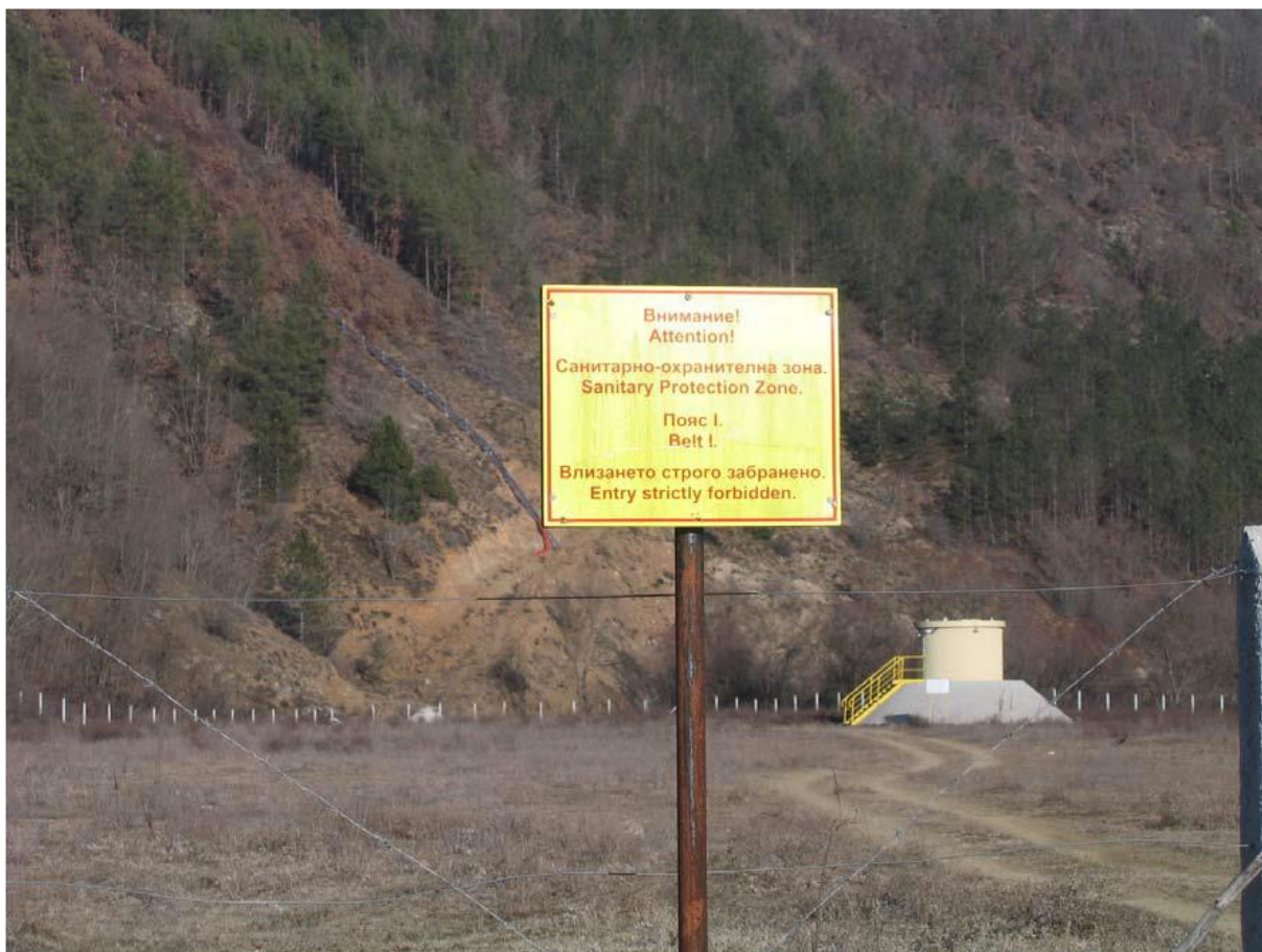
Снимка 1 – съществуващия шахтово – тръбен кладенец
