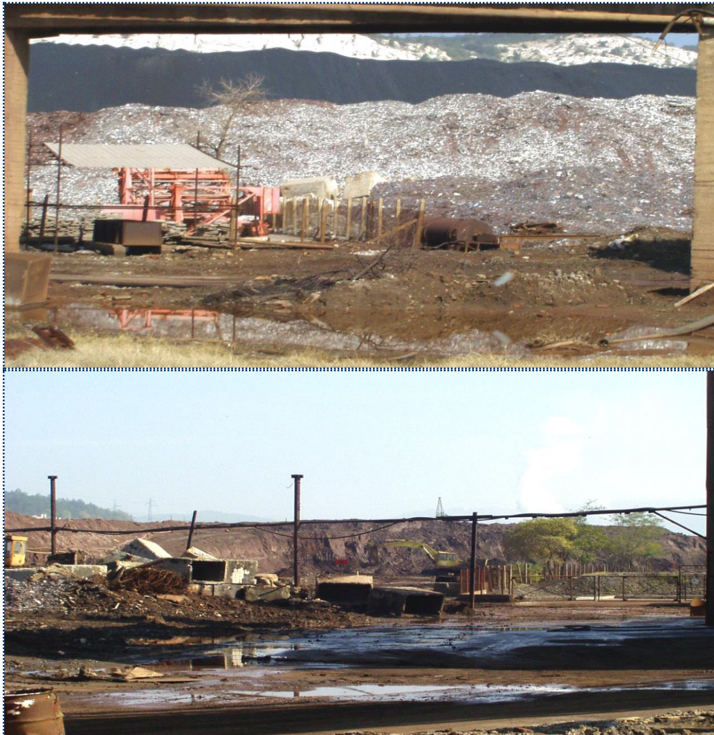
Фигура № I.1-1: Съществуваща площадка за съхранение на опасни отпадъци на Промислената площадка на ХАРМОНИ 2012 ЕООД - Нов цинков завод.
